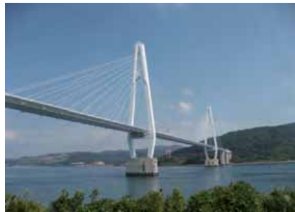
大島大橋 1988 年竣工
